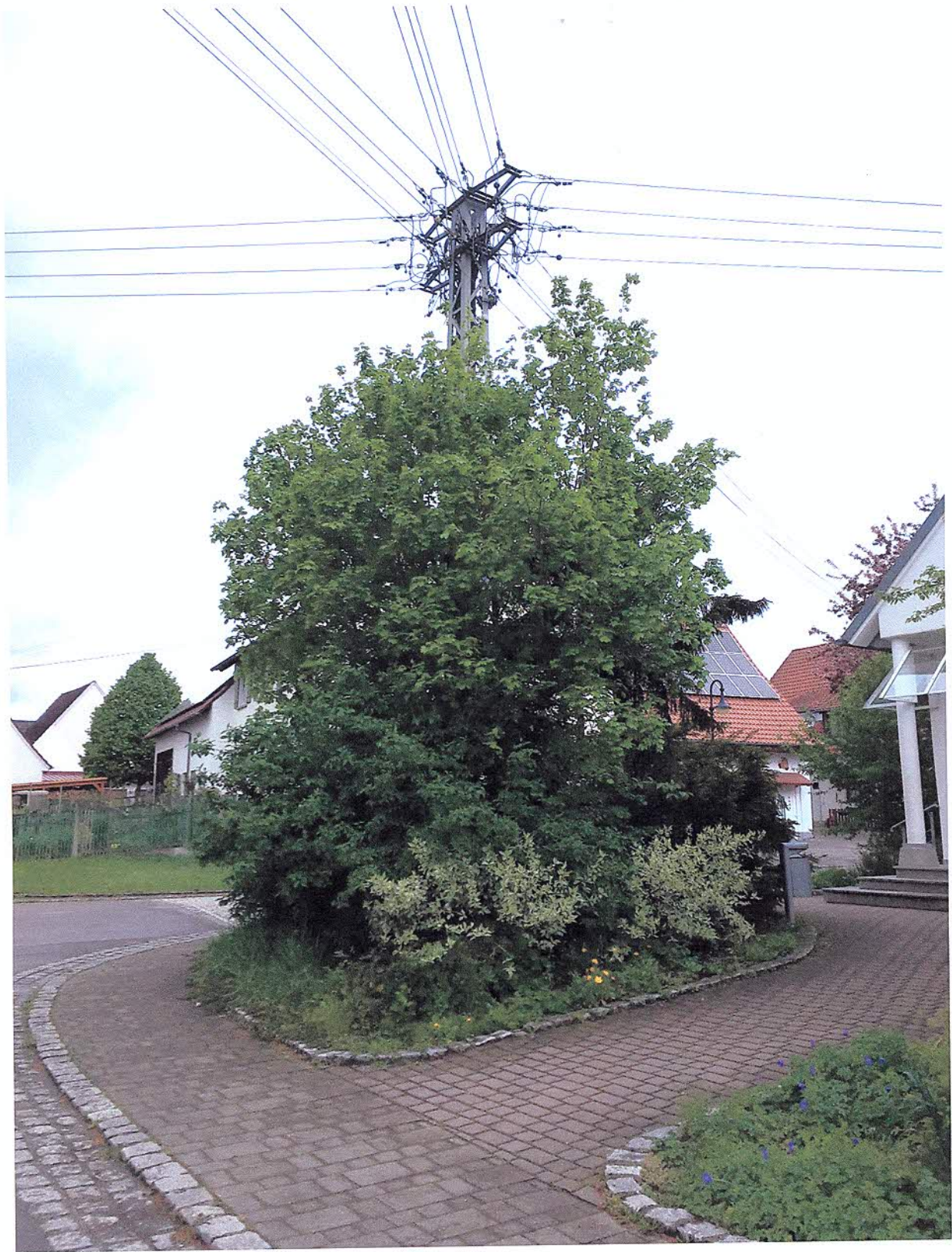
Am Gemeindehaus, begrünter Strommast (Ecke Kirchstraße – Hausener Straße)
