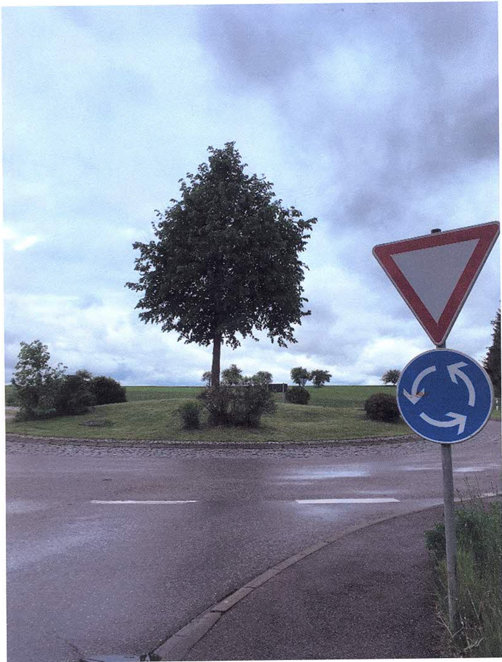
Kreisverkehr am westlichen Ortsausgang Für den Verkehr freigegeben 1997 Die Linde wurde aus dem Gemeindewald ausgegraben u. mit einer Größe von ca 7 Meter eingepflanzt
