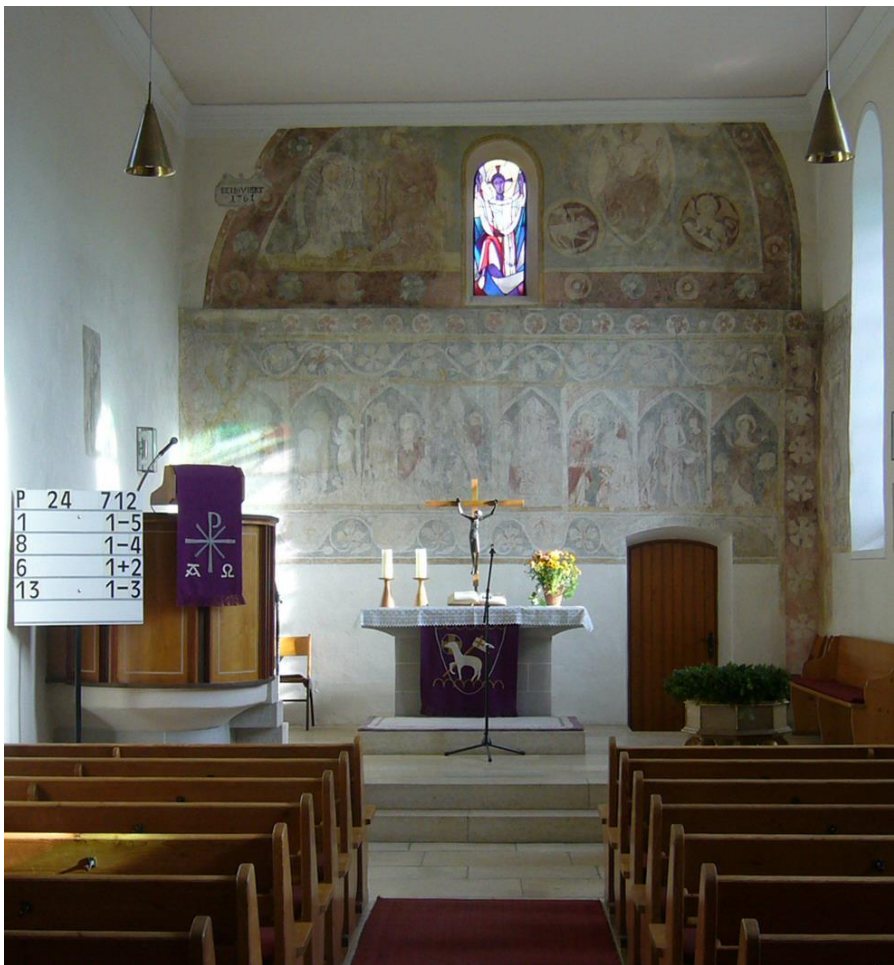
Bartholomäuskirche Setzingen Innenrenovierung 1958
